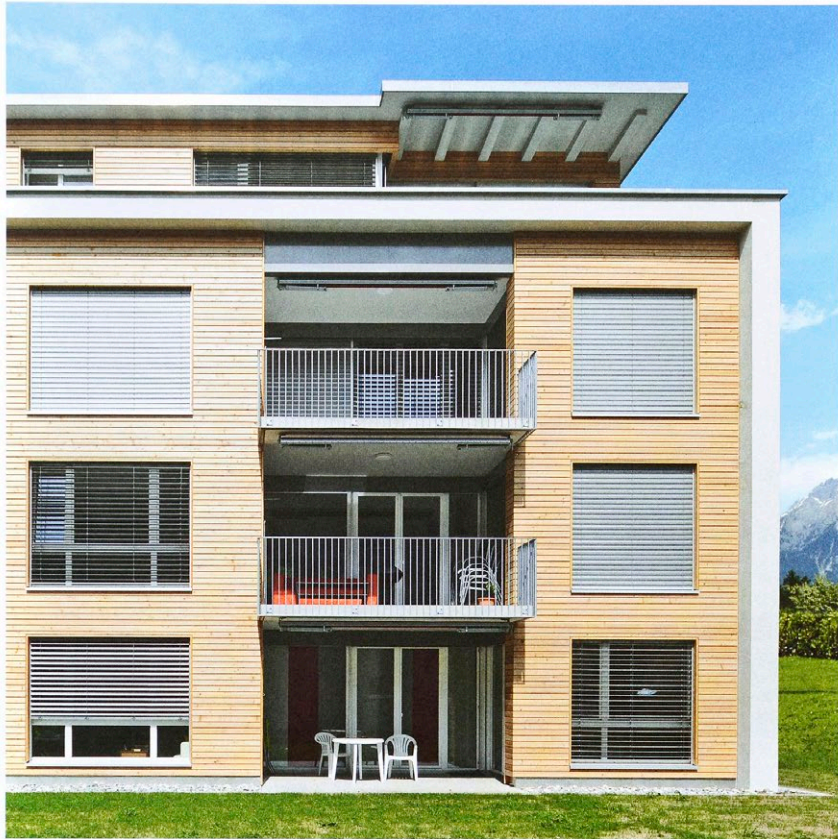
EKZ Energieberatung Stromeffizienz im Mehrfamilienhaus
